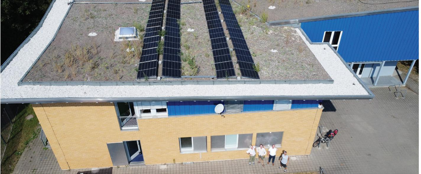
*Wird grüner und glänzender: Mit der Dachbegrünung und der Installation einer Photovoltaikanlage hat die energetische Sanierung des Jugendzentrums Blauhaus begonnen.*
